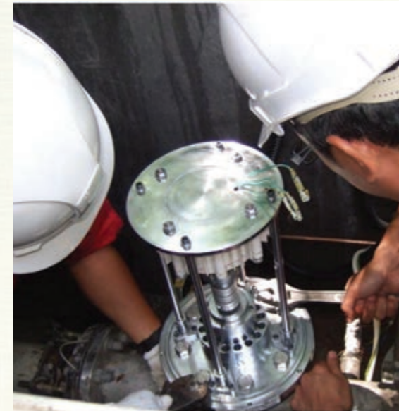
Hydro Generator System Installed in Narrow Underground Space 在狹窄的地下空間安裝水力發電系統
